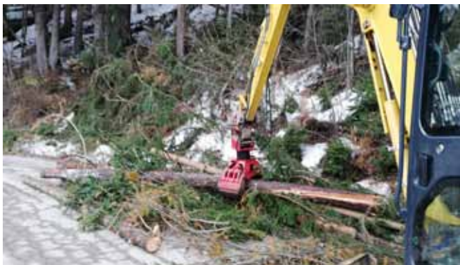
Aufräumarbeiten an der Faschingalmstraße
