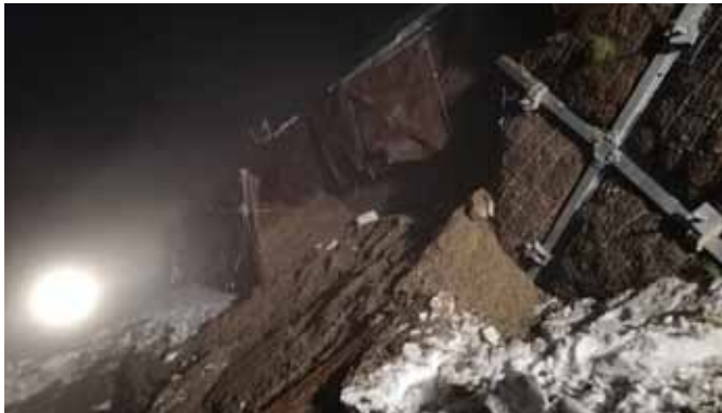
Abbruch Stützkonstruktion Wohnhaus Untergaimberg 16
