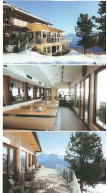
Blick auf den neuen Wintergarten
