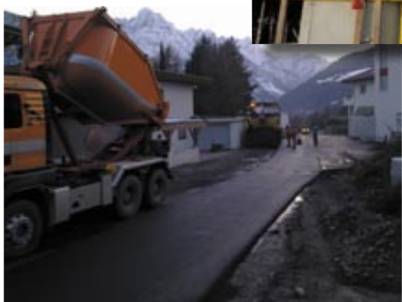
Asphaltierungsarbeiten in der Siedlung Zettlersfeldstraße
