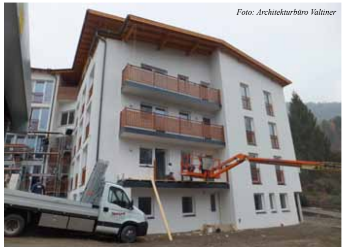
Zu- und Umbau Hotel Appartements Holunderhof, Zettersfeldstraße 36
