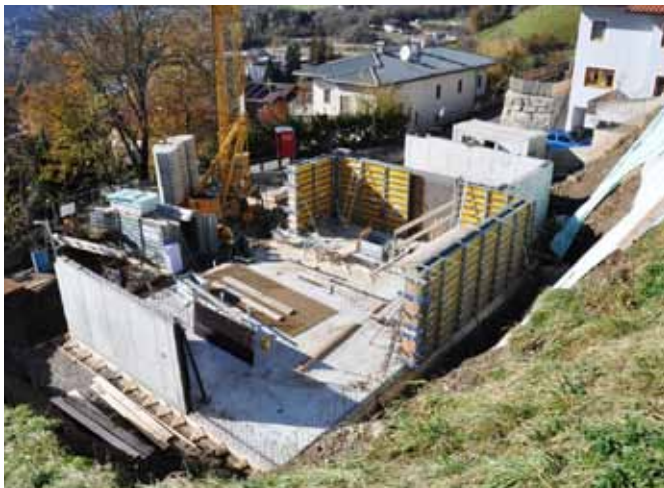
Einfamilienhaus All Mountains Sports Vertriebs GmbH, Untergaimberg 11
