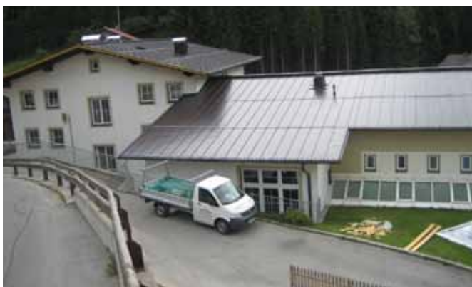
Dach bei Gebäude in Außervillgraten
