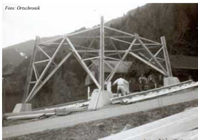
Der Masten in der Nähe vom Bauernhaus vulgo Wachtlechner im Bau.
