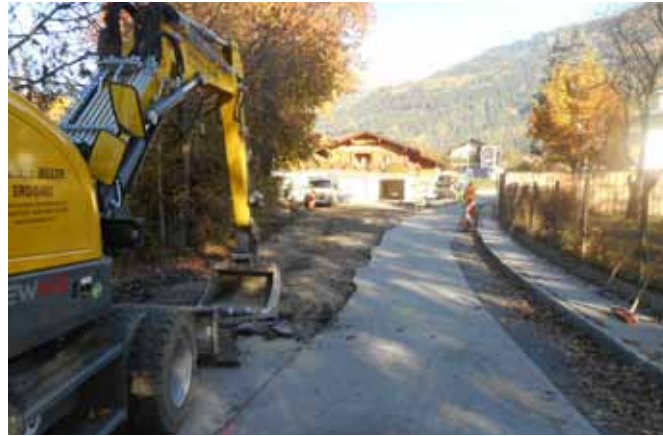
Heuer wurden viele Sanierungs- und Asphaltierungsarbeiten im gesamten Gemeindegebiet durchgeführt.
