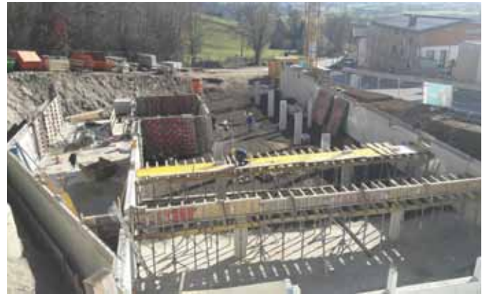
Neubau einer Wohnanlage, Zettersfeldstraße 41
