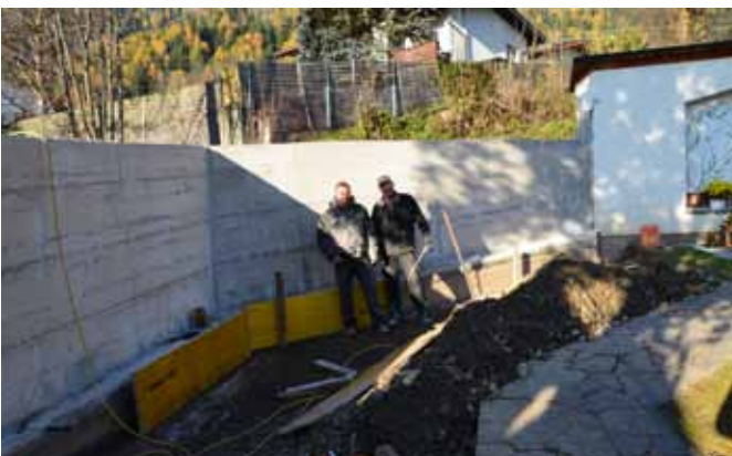
Neuerrichtung Urnengrabanlage Friedhof Gaimberg
