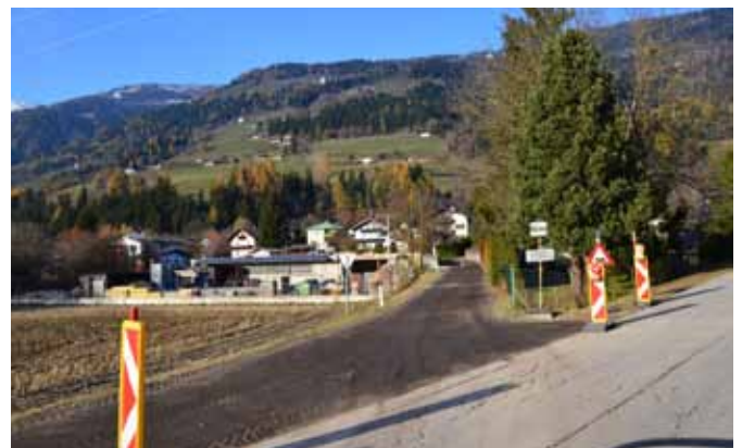
Sanierungs- und Asphaltierungsarbeiten im Bereich der Wartschensiedlung
