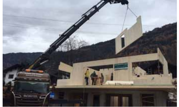
Neubau Einfamilienwohnhaus, Grafendorf 42
