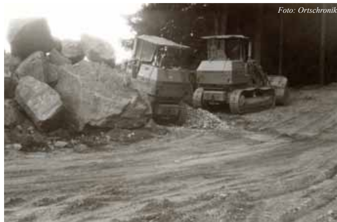
Bau der Faschingalmstraße.
