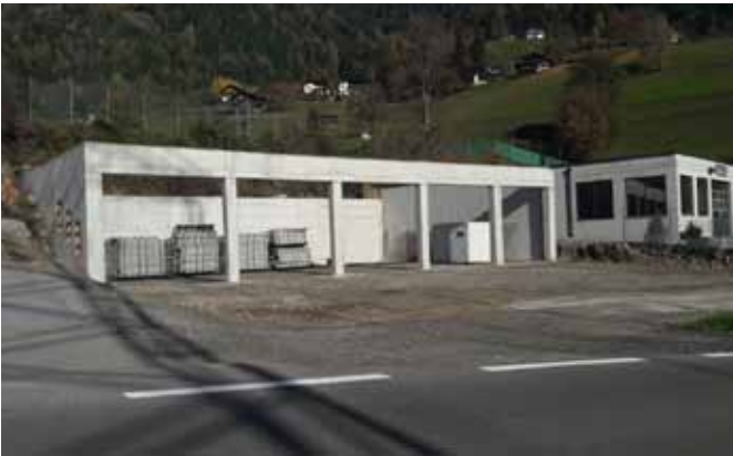
Neubau einer Lagerhalle, Zettersfeldstraße
