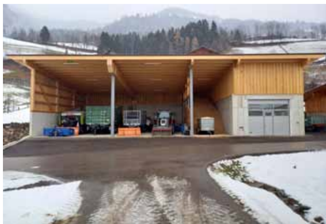
Neubau landwirtschaftlicher Lagerschuppen mit Garage und Hackgutraum Untergaimberg 1
