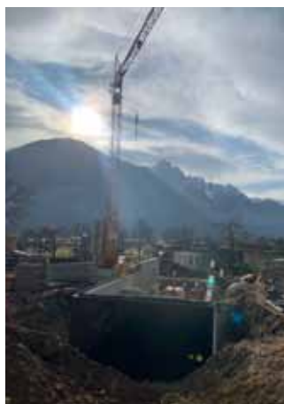
Neubau Einfamilienwohnhaus Wartschensiedlung 14
