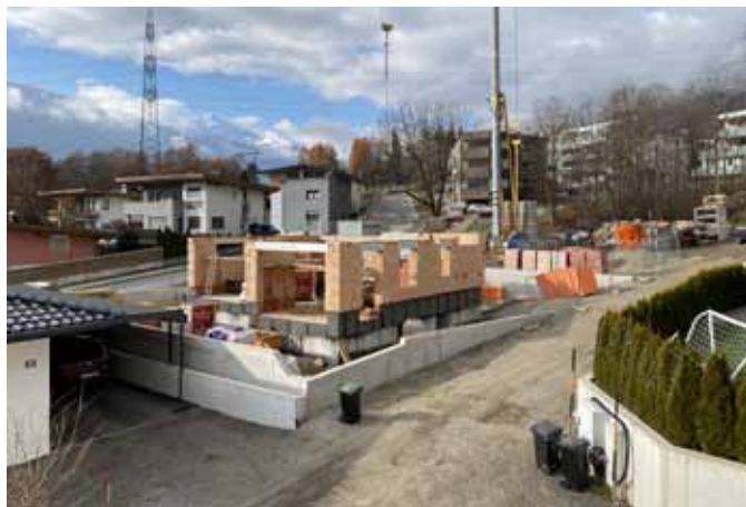
Neubau Einfamilienwohnhaus Peheimweg 21.
