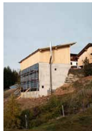
Neubau Hackschnitzelheizung, Zetttersfeld 24
