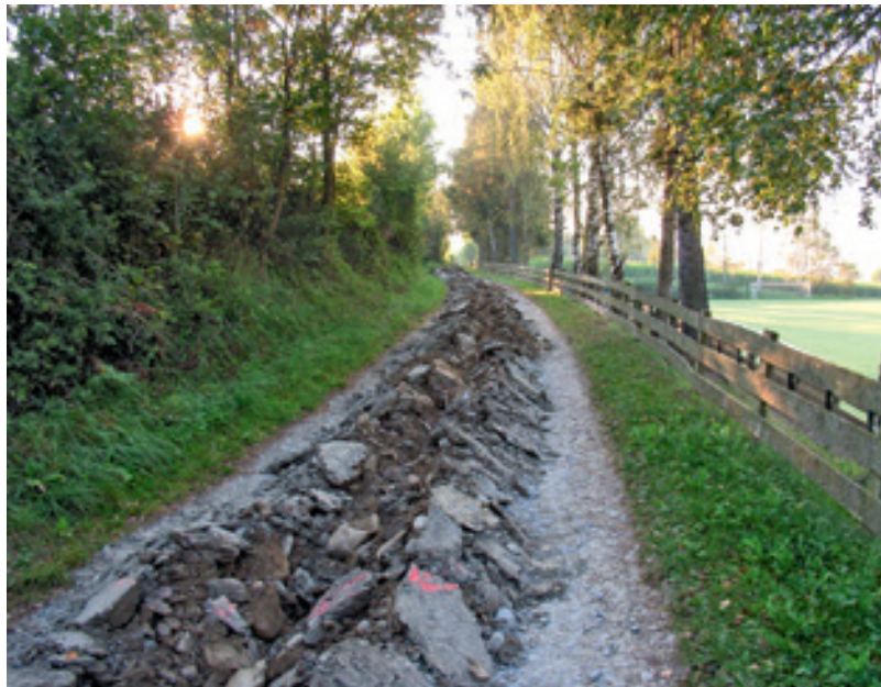
Gentechnisch manipulierter Maulwurf in Oberlienz gesichtet – Die Kabelverlegung in Pflügetechnik für die Breitbanderschließung im Bereich Schleinitz-Stadion. Für eine Strecke von ca. 1,8 km benötigte der Pflug lediglich 3 Stunden.
