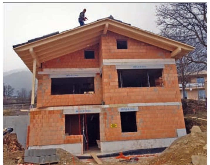
Sandra Schwarzl und Manuel Oberhauser errichten im Mußhauserfeld ein Einfamilienwohnhaus mit Garage (Baubeginn Februar 2019).
