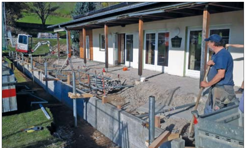
Walter Ruggenthaler beim Betonieren des Fundamentes.
