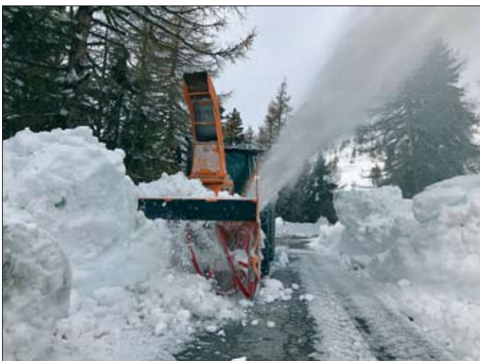
Um die Fahrbahnbreite wieder herzustellen, müssen die Schneemassen weggefräst werden.
