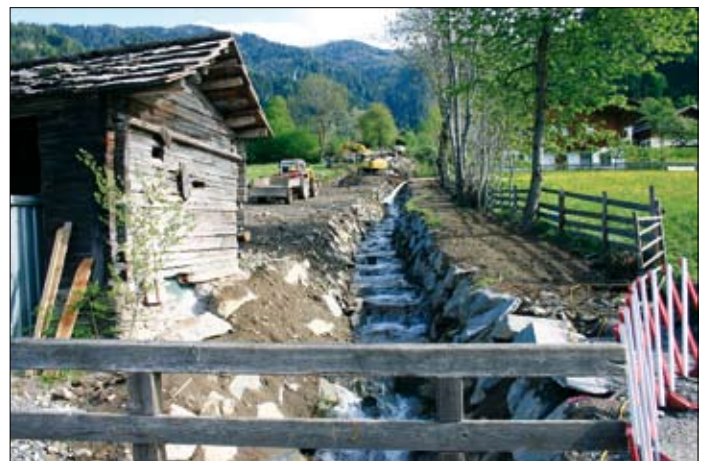
2005: Der Zauchenbach wird von Unterthaler bis Kollnig verbaut. Auf der Seite mit dem Zaun wurden die Rohre für das Kraftwerk eingegraben.
