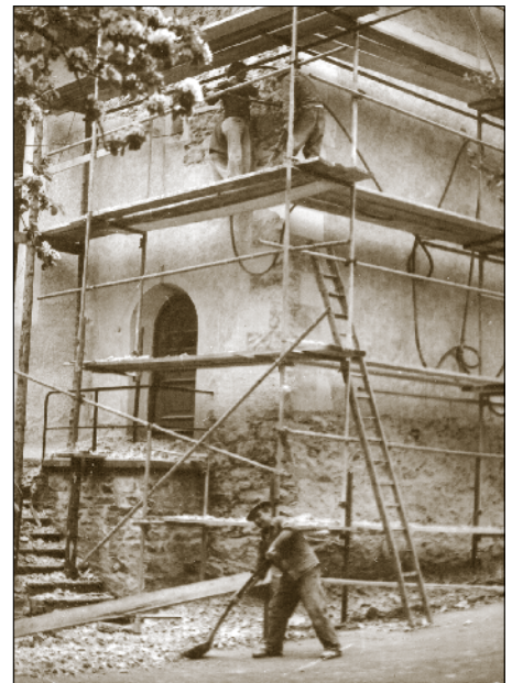
Der alte Putz wird abgeschremmt. Toni Waldner bei der Arbeit. Die Tür ist der alte Eingang zur Sakristei, heute zugemauert.
