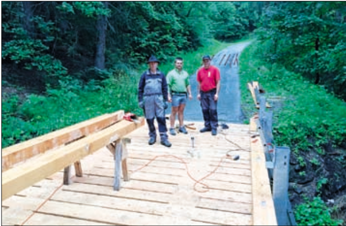
Brückenrevision „Bocha Brücke“.
