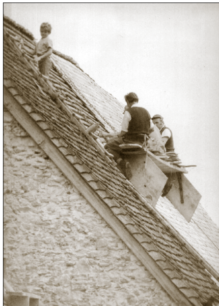
Die Westfassade wird neu gedeckt. Alle helfen mit.
