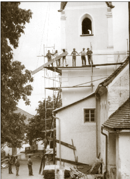
Im Bild der generalüberholte Turm. Der Putz wurde abgeschremmt und der Turm von Andrä Mußhauser (Trattner) verputzt. Maler Pokorny aus Dölsach malte den Turm. Von ihm wurde auch das Abendmahlbild restauriert.
