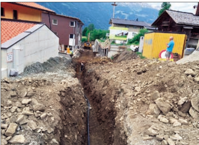
Zufahrtsweg Wohnanlage Kammerlandergarten.
